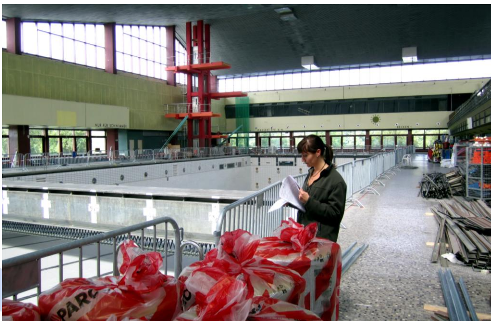
Alicja Nieczajew, Bauingenieurin der BBB Infra auf der Baustelle am Sachsendamm.
