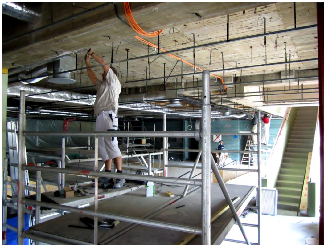
In der Lehrschwimmhalle wird die neue Abhangdecke montiert
