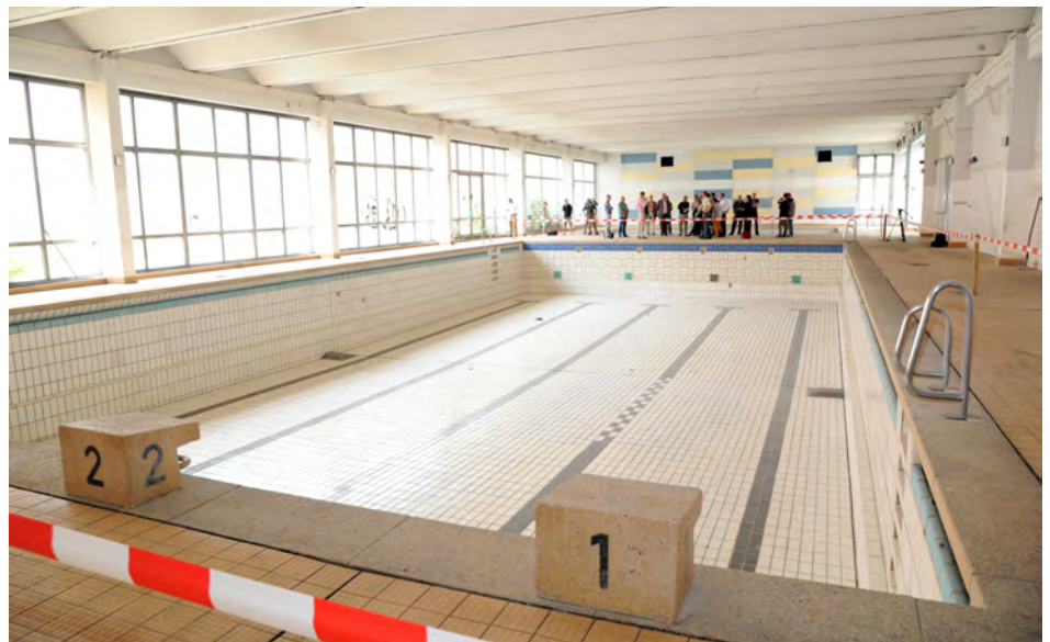
Leere Becken: Die Sanierung kommt nun in Fahrt.
